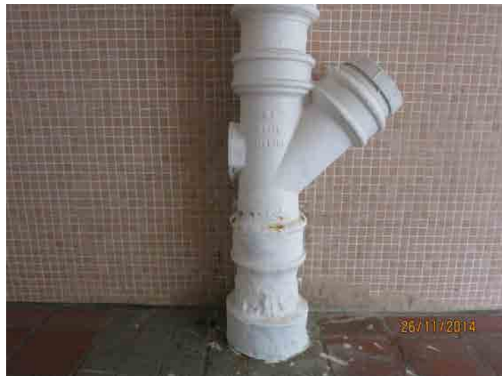
P4平台雨水渠
